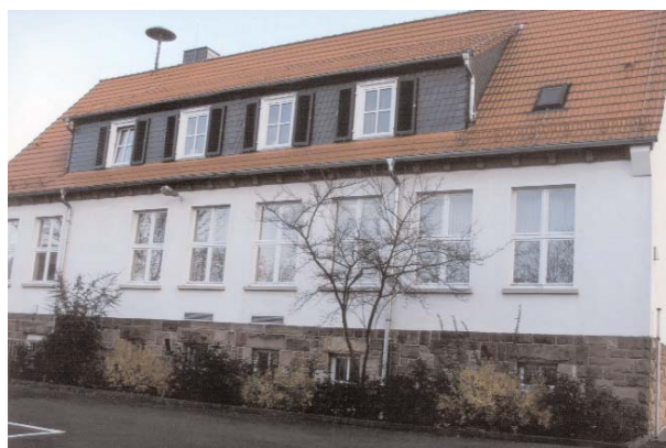
Neue Schule in Edelzell mit der erkennbaren Fensterfront der früheren Schulsäle im Erdgeschoss
